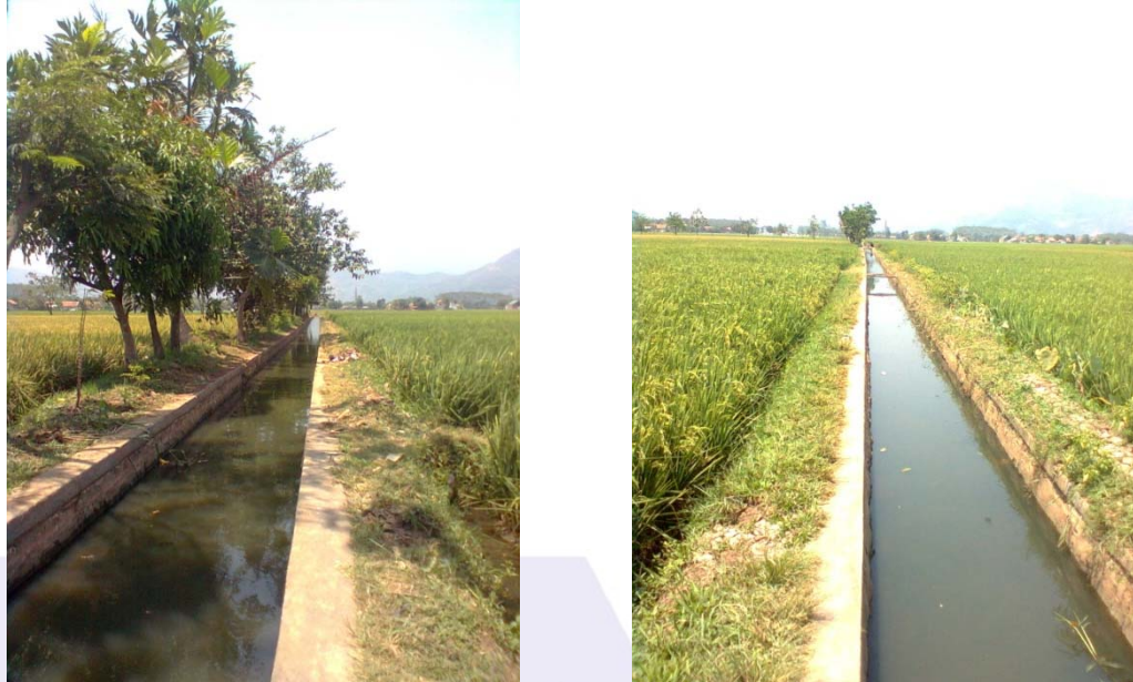
Gambar 3 – Contoh buffer zone berbentuk parit
